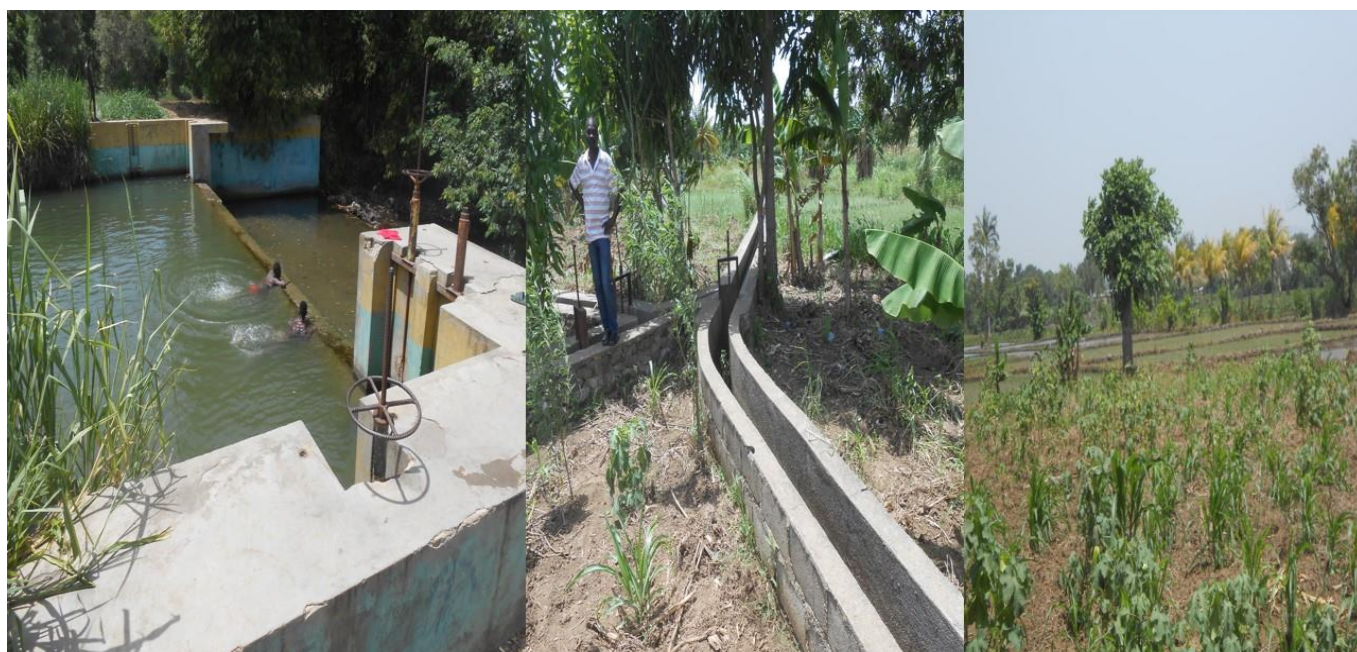
Figure 5 : Micro barrage construit par l'AAA à Haut Maribahoux dans la commune de Ouanaminthe dans le Nord'Est d'Haïti
