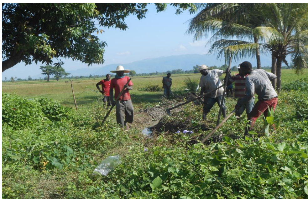
Figure 2 : Travaux de nettoyage de canaux quaternaires
