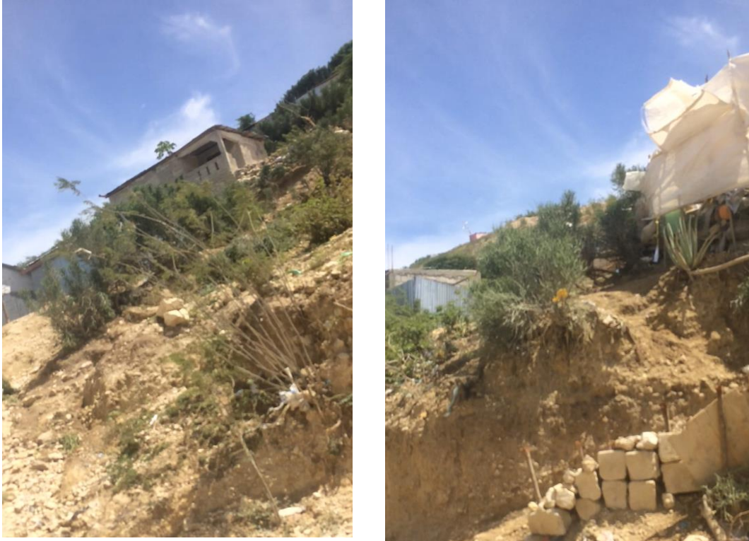
Figure 6. Maisons et cabanes construites par les habitants à Canaan 4. © Jean Wisnel St Juste, 25 juin 2021.
